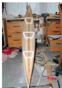
Bild 07 Der Rumpf im Rohbau
